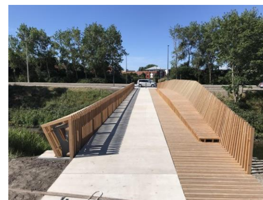
Passerelle cyclo-piétonne de la ZAC Coubertin reliant le Fort-Nieulay au centre-ville :
