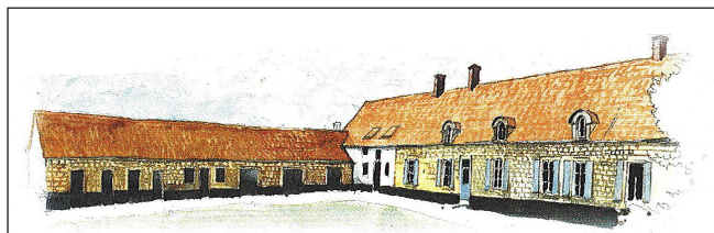
Ferme à cour ouverte, murs en moellons de grès, pannes flamandes anciennes, Portes et fenêtres à impostes avec encadrements en pierre de Marquise, dans le secteur sud ouest du territoire, sur Fiennes et les communes limitrophes...
