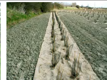
privilégier les toiles biodégradables
