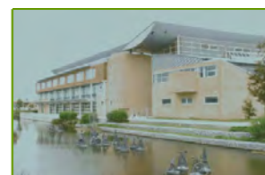
Le lycée HQE de Calais
