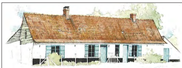
Ferme d'Artois en torchis. Maison de type picard : murs en torchis avec soubassement en briques goudronné ; toiture en pannes de pays mécaniques et coyau ; port bois à imposte.
